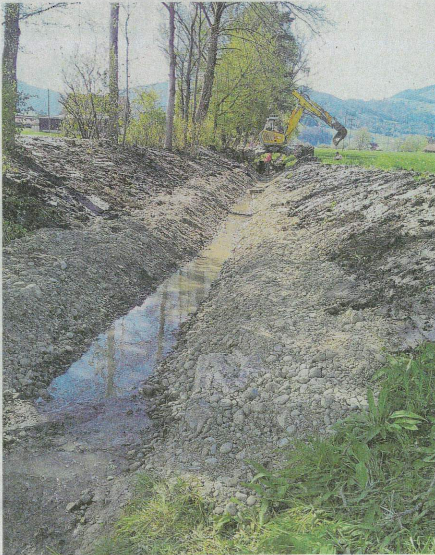
Der kanalartige Pfählmadgraben zwischen Oberriet und Altstätten wurde 2017 auf einer Länge von rund 300 Metern zu einem naturnahen Gewässer umgebaut.
