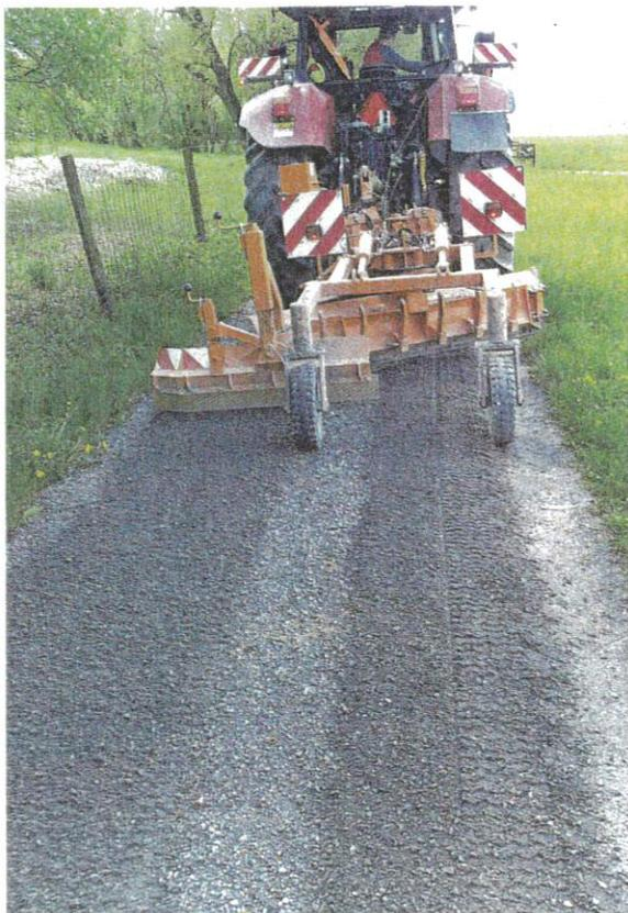
Die bekieseten Strassen werden mit dem werkeigenen Strassenhobel bearbeitet. Insgesamt wurde 4000 m<sup>3</sup> Kies eingebracht. Bild: pd
